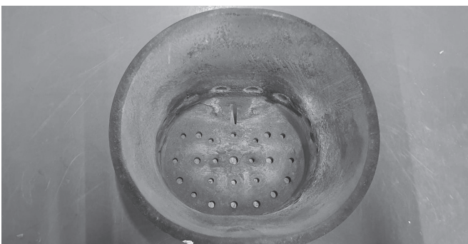
...und nach einer sorgfältigen Reinigung.
